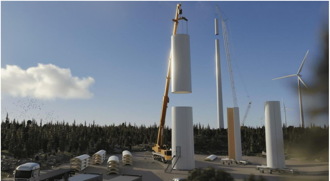
Montering av vindkraftstorn i trä.
