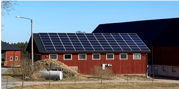
20 kW solanläggning (2018) på gårdsverkstad . 18 000 kWh/år
