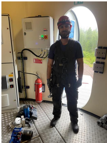
Coman på väg upp i Klämman 1. Till vänster på golvet ligger verktyg och till höger ligger muttrar.
