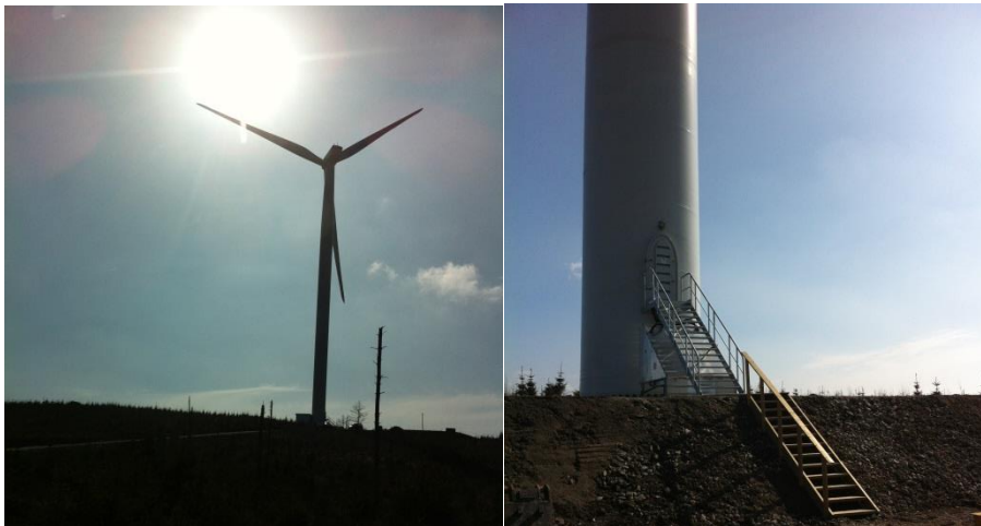
Turbin 7 i Askome vindpark. Till 25 % ägd av VVEF. Navhöjd 98,3 m, rotordiameter 103 m, generator 2,75 MW.
