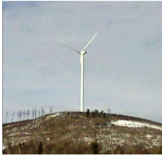
Verk 7 i Askome vindpark
